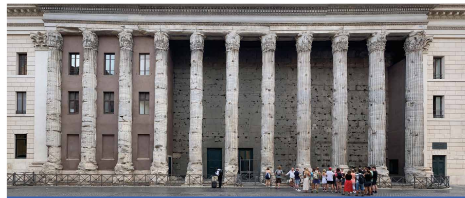
Le siège historique de la Chambre de commerce de Rome sur la Piazza di Pietra
