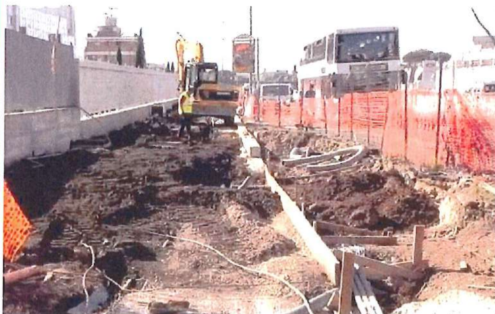
Uno dei cantieri sulla Tiburtina, all'altezza di San Basilio
