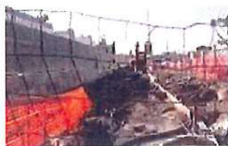
Cantiere sulla Tiburtina
